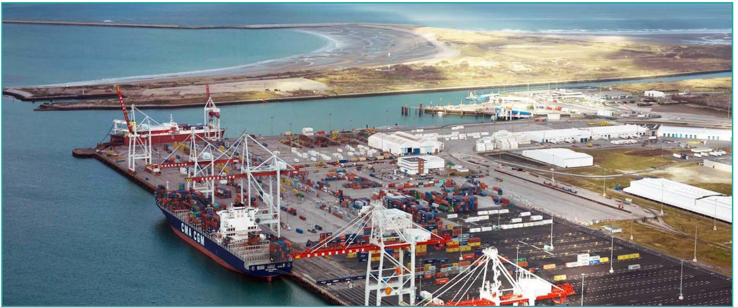
Figure 2 : Vue aérienne de l'actuel terminal des Flandres du port de Dunkerque
